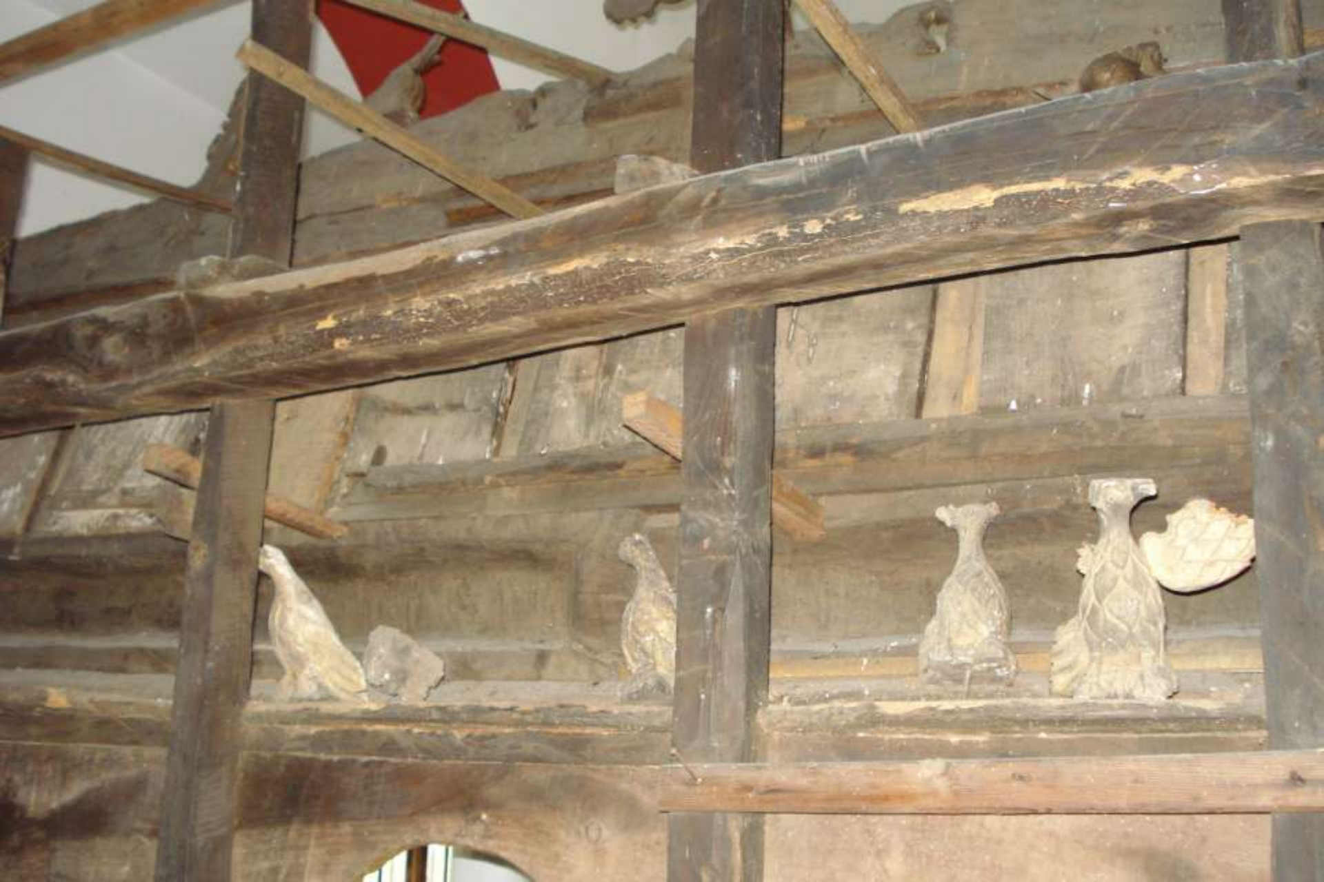
Εσωτερική πλευρά του τέμπλου.
